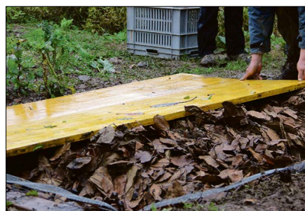
Über die Strohisolation kommen eine Wolldecke, Nussbaumlaub, ein Abdeckvlies, Schaltafeln und nochmals ein Abdeckvlies.
